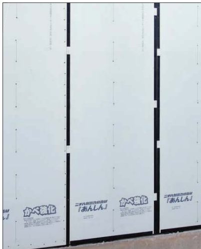
高倍率仕様施工の様子
